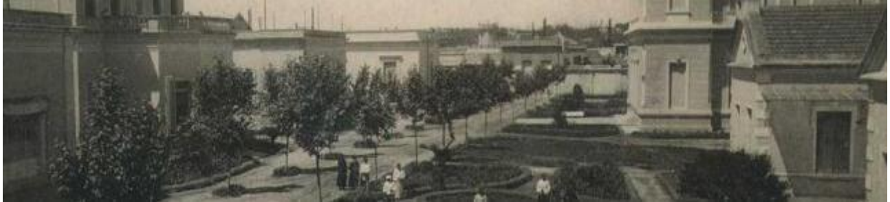
Patios laterales del Hospital Nacional de Clínicas. Fotografía Colección MuVA
